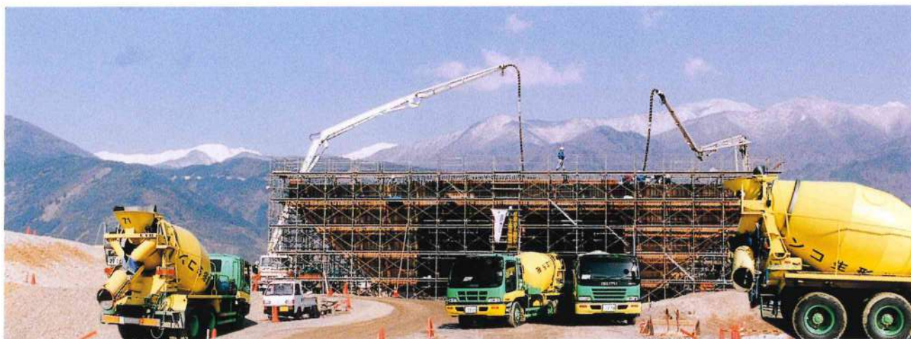
中部横断自動車道 白根インターチェンジ工事
